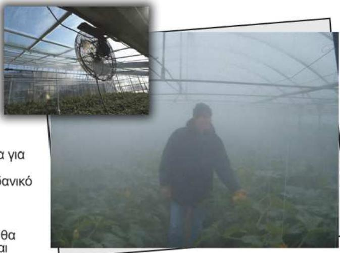
Το σύστημα υδρονέφωσης HydroCooling λειτουργεί σε μία πίεση 70 bar και μετατρέπει το νερό σε μικρό-σταγονίδια διαμέτρου περίπου 10 μικρά, τα οποία αιωρούνται στον αέρα, δημιουργώντας το αποτέλεσμα της ομίχλης.
